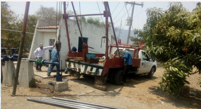
Ampliación de Red de Descarga Pozo Laureles por Agotamiento de manto acuífero. Costo Aprox. $20,000.00
