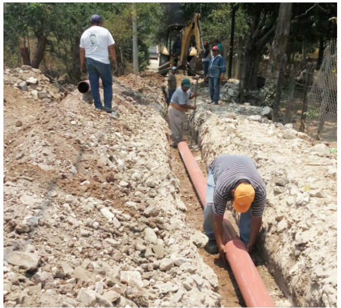
Instalación de Red Drenaje calle Morelos Delegación La Higuera. Costo Aprox. $25,000.00
