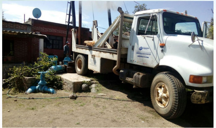
Cambio de Bomba en Equipo de Pozo N°9. Costo Aprox. $54,900.00
