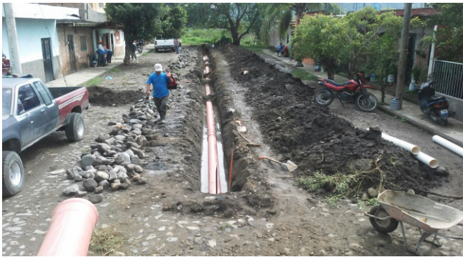
Cambiamos 52 metros de Red Drenaje en la Calle Emiliano Zapata con un costo aprox. $15,000.00
