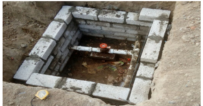
Instalación Red de Agua calle Tajín, Vistas de la Floresta. Costo Aprox. $8,000.00
