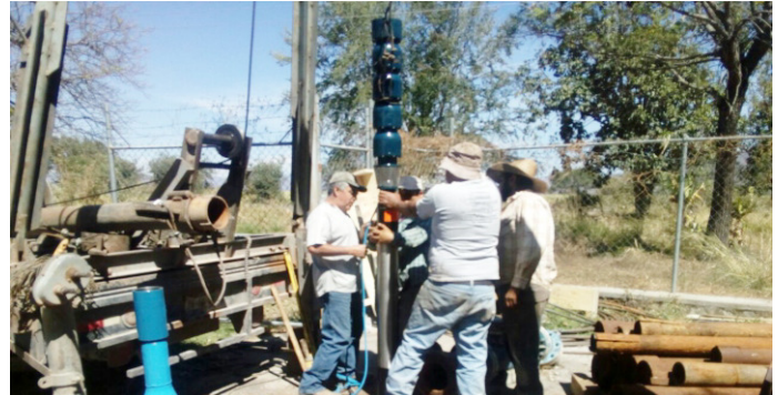
Cambio Equipo de Bombeo Pozo N°4 (dañado) Costo Aprox. $76,000.00
