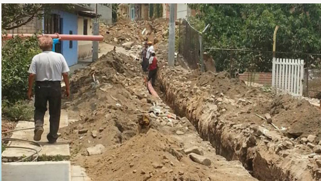
Cambio Redes de Drenaje en Platanar. Costo Aprox. $60,000.00
