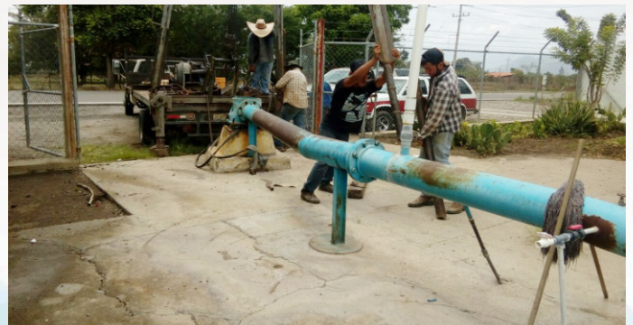
Reparación Equipo de Bombeo Pozo N°3. Costo Aprox. $56,000.00
