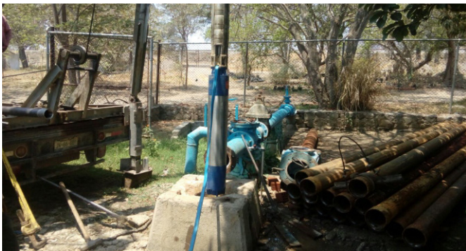
Reparación Equipo de Bombeo Pozo N°5
