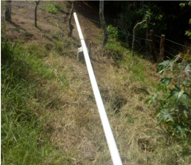
Modificación Red Drenaje Descarga Planta Tratadora de Aguas Residuales en Nuevo poblado. Costo Aprox. $6,000.00
