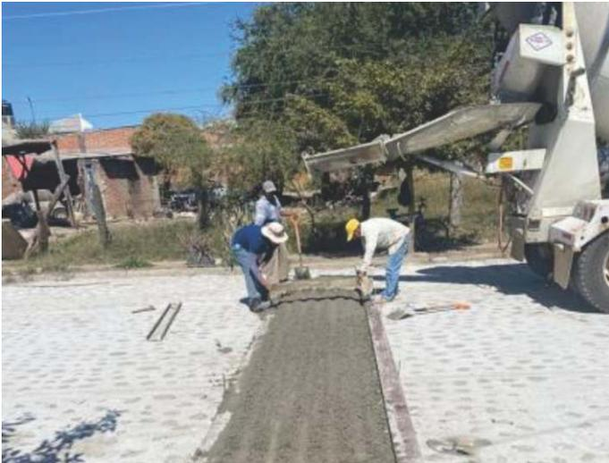
Con la colocación de tres topes reductores de velocidad de concreto, uno de ellos culminando totalmente en la Av. Tizatirla y los otros dos aún en proceso por calle Abasolo en las afueras del Cementerio Municipal Fray Antonio de Segovia.
