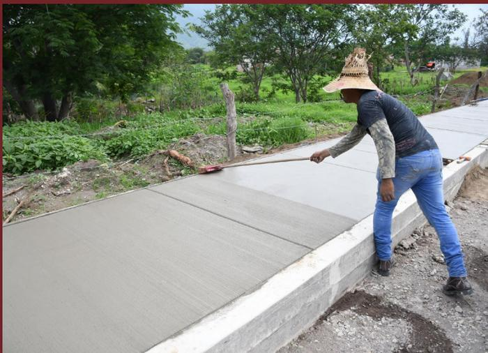
Con recurso FAIS construimos la Obra Integral de pavimento con concreto hidráulico, banquetas, machuelos, red sanitaria e hidráulica en la calle Zapopan en la cabecera municipal, con un monto de \$3'440,308.77
