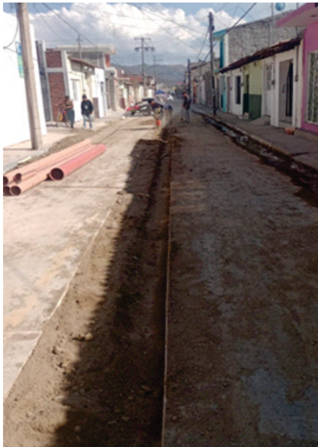
Cambio de 86 m de drenaje en calle Morelos.
