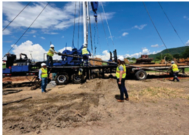
Construcción del sistema de agua potable mediante
