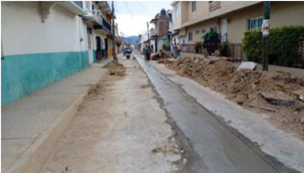
Cambio de 128 m. de drenaje en calle Javier Mina, en su Segunda Etapa
