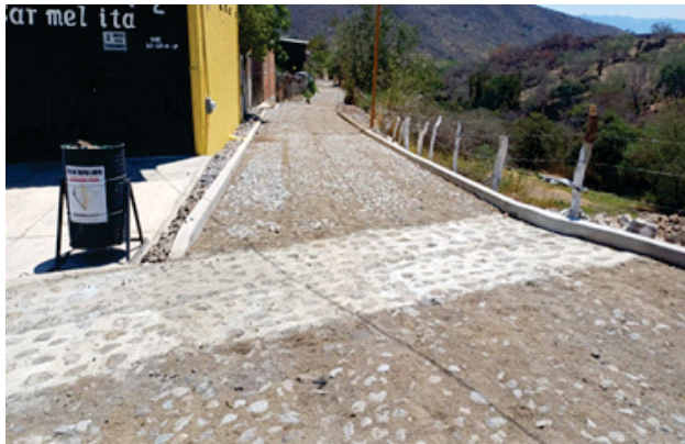
Construcción de 1,350 m 2 de empedrado ecológico tradicional, machuelos y banquetas en calle Camino Viejo a San Miguel, colonia Cándido de la Cruz.
